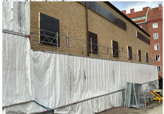
Fasadskydd och bulleråtgärder på Stadsteaterns fasad.
