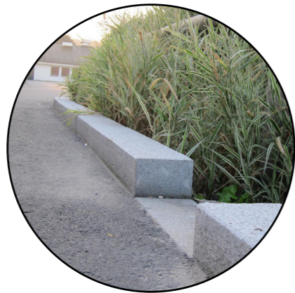
Öppningar i kantsten leder ned dagvatten i växtbäddar
